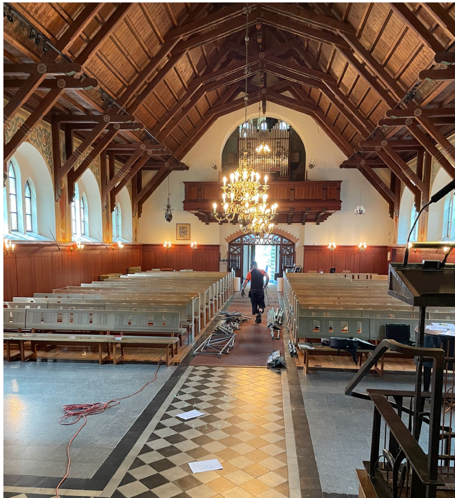
Nacka kyrka är en av flera byggnader med kulturhistoriskt värde. Rakt under kyrkan kommer Blå linjes spårtunnlar att sprängas ut. Här pågår arbete med att undersöka Nacka kyrka. Foto: Region Stockholm
