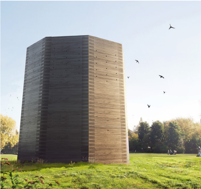
Oftast byggs ventilationstornen för att smälta in i stadsmiljön. Men det finns undantag. Ett fågeltorn mellan Akalla och Barkarby, och ett insekshotell på kolerakyrkogården vid Gullmarsplan, är exempel på ventilationstorn som får dubbla funktioner.
