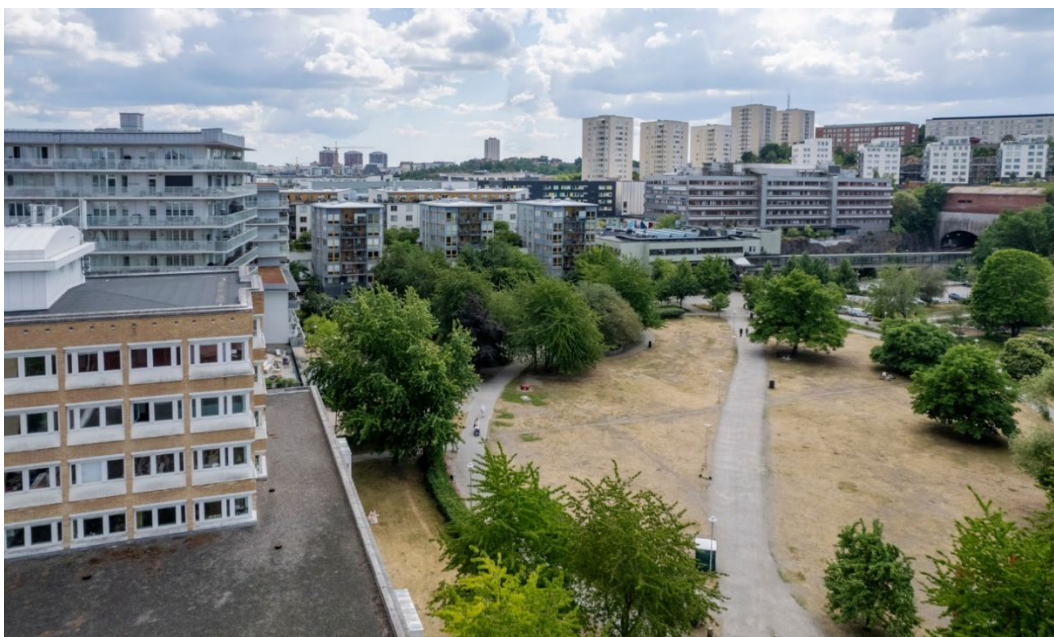
Figur 9. Station Liljeholmen med närområde. Den nya stationen byggs i anslutning till den befintliga. Bilden visar Trekantsparken i riktning mot den befintliga tunnelbanestationen.
