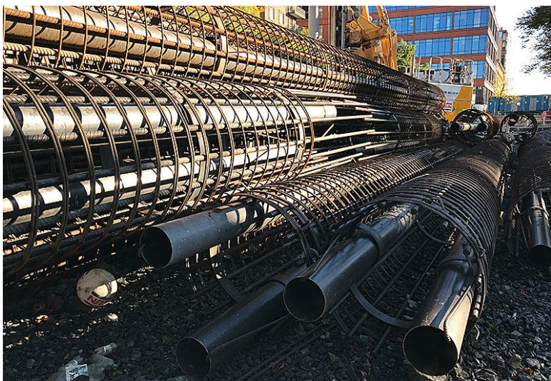
Figur 41. Armeringskorgar för sekantpåle samt rör för ridåinjektering och dubb.
