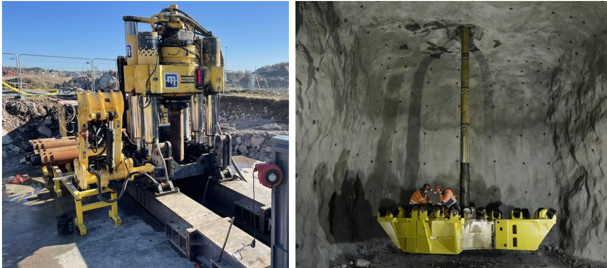
Figur 45. Tv. Raisebormaskin sedd från ytan. Foto: Region Stockholm. Th. Raiseborring. Borrkrona monteras inför raiseborring av vertikalschakt. Foto: Master Drilling Europe.
