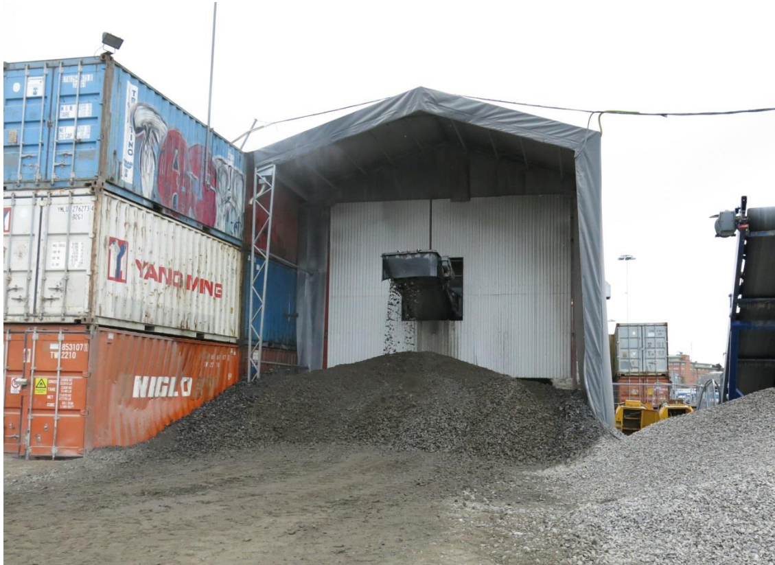
Figur 2 Exempel på en inklädd krossanläggning.
