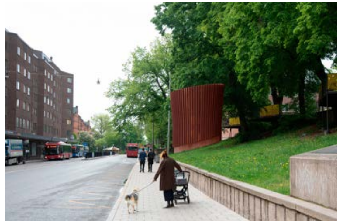
115: Överbyggnad för brandgasschakt på Fridhemsgatan i slänten nedanför skolan.
