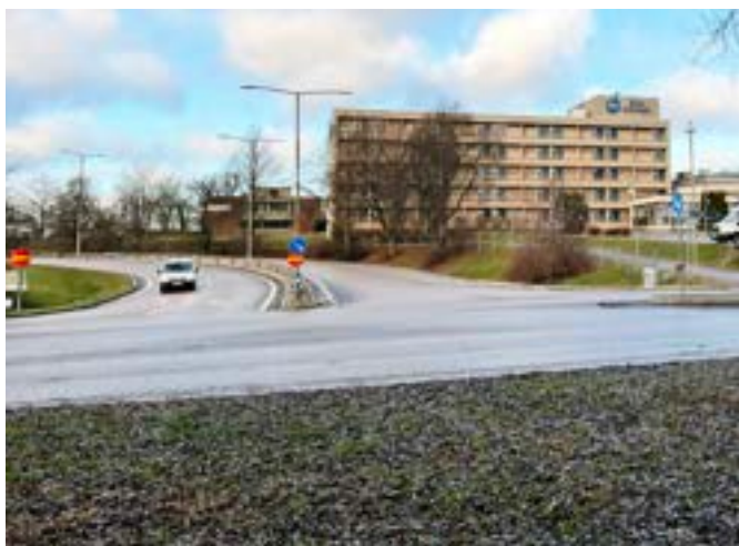
172. Hotellbyggnad öster om spåren. Miljön präglas av infrastruktur och är inte anpassad för oskyddade trafikanter.
