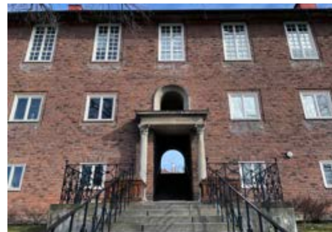
Figur 55. Brännkyrkas församlingshus från 1925, i nyklassicistisk stil. Genom portiken skymtas en skorsten från en elanläggning på andra sidan berget.
