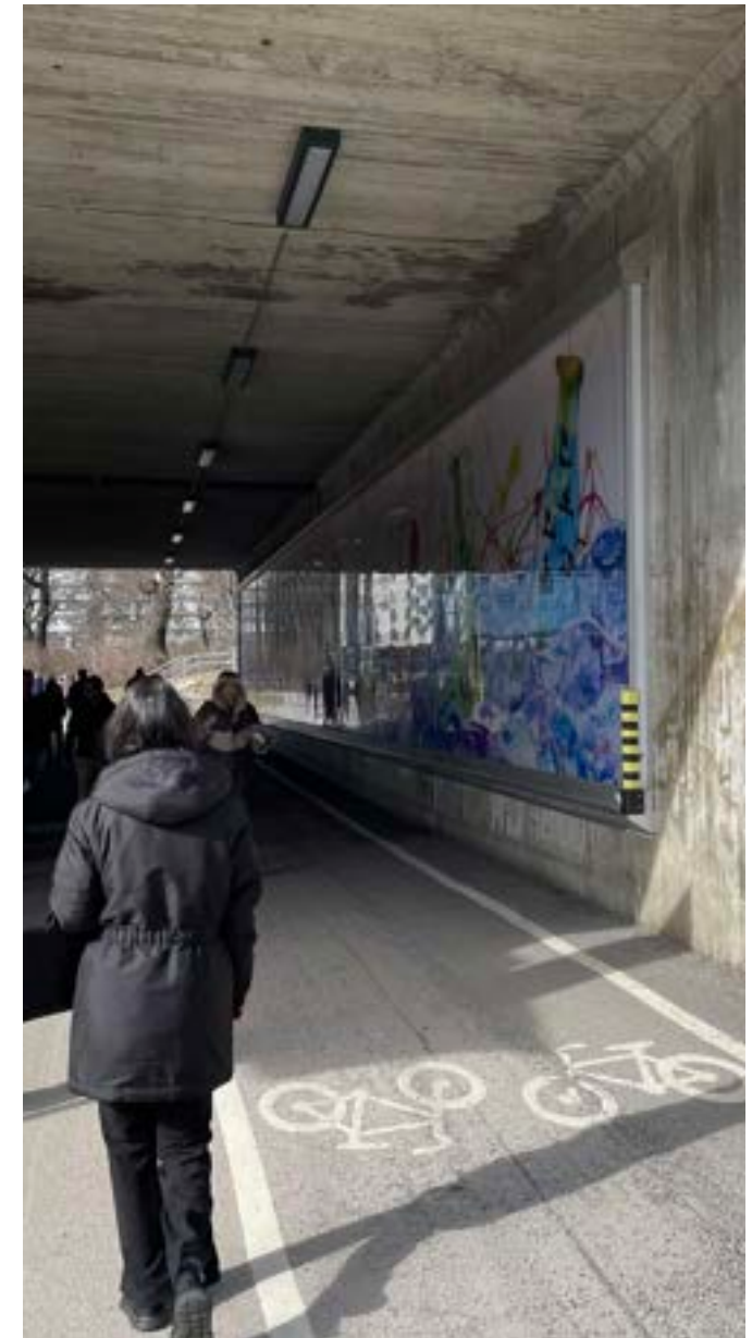
Figur 3. Exempel på koppling: en tunnelpassage under Södertäljevägen i Liljeholmen.
