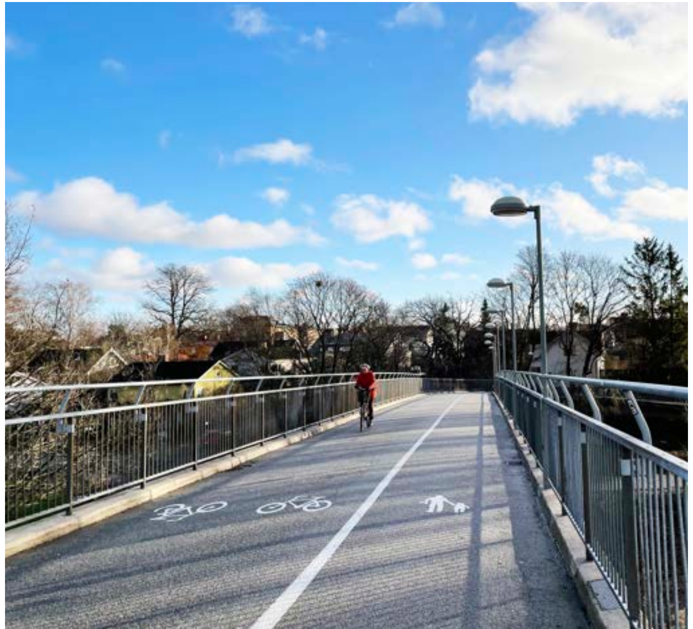
Figur 199. På södra sidan av Älvsjö broväg når man småhusområdet Örby.
