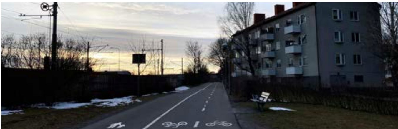
Figur 120. En gång- och cykelväg löper längs tvärbanespårets norra sida mellan Årstaberg och Årstafältet.
