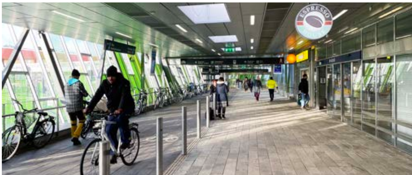
Figur 197. Den stora resecentrumanläggningen utgör en koppling över spårområdet för oskyddade trafikanter, mellan Älvsjö torg och mässområdet.
