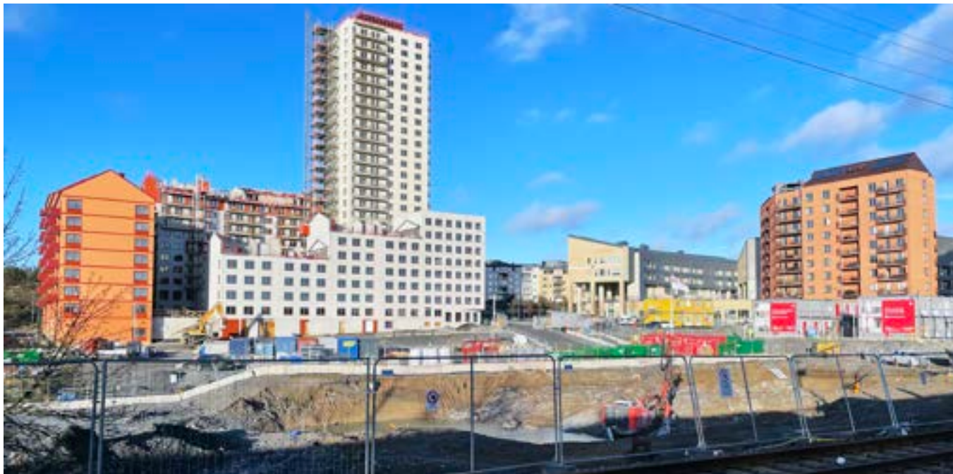
Figur 91. Den nya bebyggelsen norr om spåren vid Årstaberg. Närmast i bild pågår bygget av den nya stationsplatsen i två nivåer.
