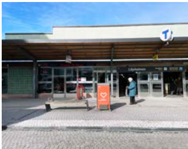
Figur 48. Södra biljetthallen har ett skärmtak över entrén mot torget.
