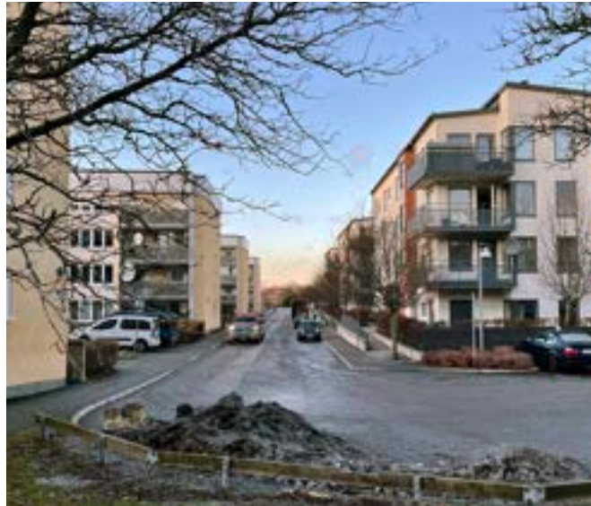
Figur 133. Bostadsbebyggelsen i Östberga består främst av lamellhus i fyra våningar från 1960-talet (vänster), samt stadsvillor från 2000-talet (höger). Bilden visar en så kallad matargata, typisk för 60-talets ideal om trafikseparering. Bilden är tagen i riktning mot norr, långt bort mellan husen syns punkthusen på Nybohovsberget i Liljeholmen.
