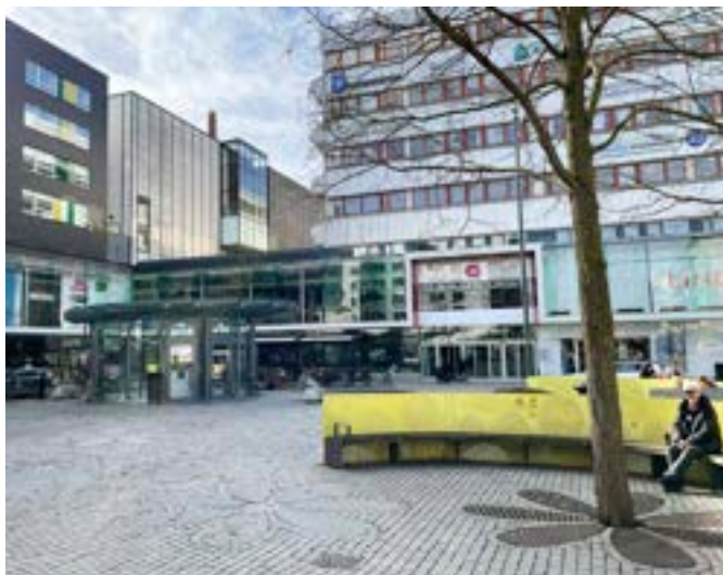
Figur 45. Liljeholmstorget omges av flera stora byggnadsvolymer. På bilden syns galleria och kontorshus samt ett trapphus från torget ned till gallerians källarplan.
