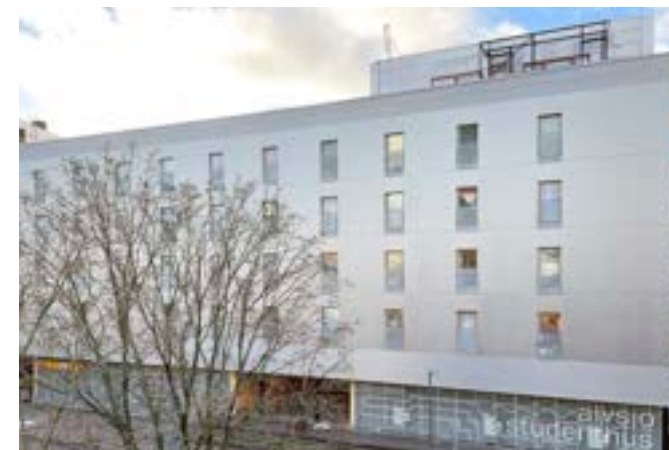
Figur 166. I ett ombyggt kontorshus med en fasad i borstad aluminium mitt emot mässhallen är det idag studentbostäder.
