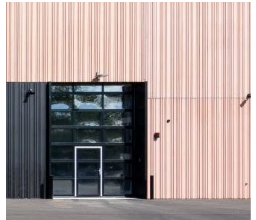
5.2.5 Fasadelement med matrisgjuen betongyta
