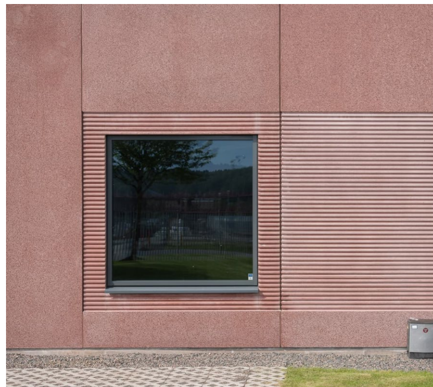
5.2.1 Prefabricerade fasadelement av betong med varierad ytbehandling
