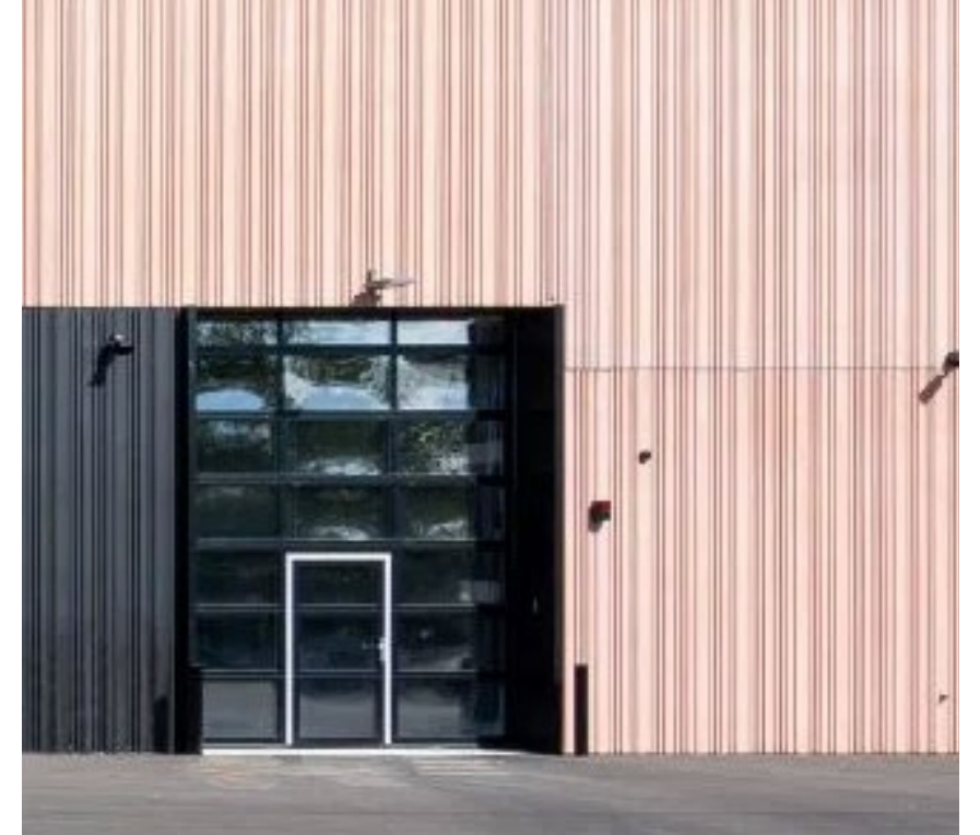
5.2.5 Fasadelement med matrisgjuen betongyta
