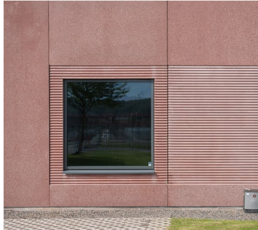
5.2.1 Prefabricerade fasadelement av betong med varierad ytbehandling
