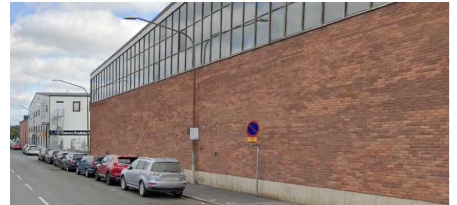
2.1.3.1 Befintliga byggnader vid Varuvägen.
