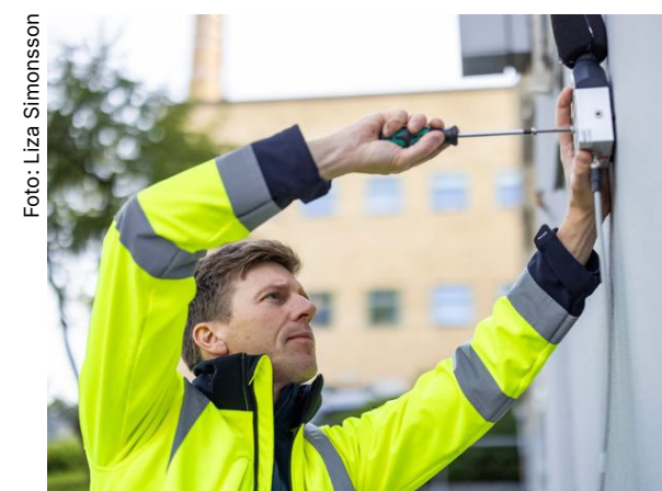
Foto: Liza Simonsson Många mätningar håller koll på hur bygget påverkar omgivningen. På bilden monteras en decibelmätare på fasaden av ett hus.
