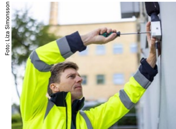
Många mätningar håller koll på hur bygget påverkar omgivningen. På bilden monteras en decibelmätare på fasaden av ett hus.
